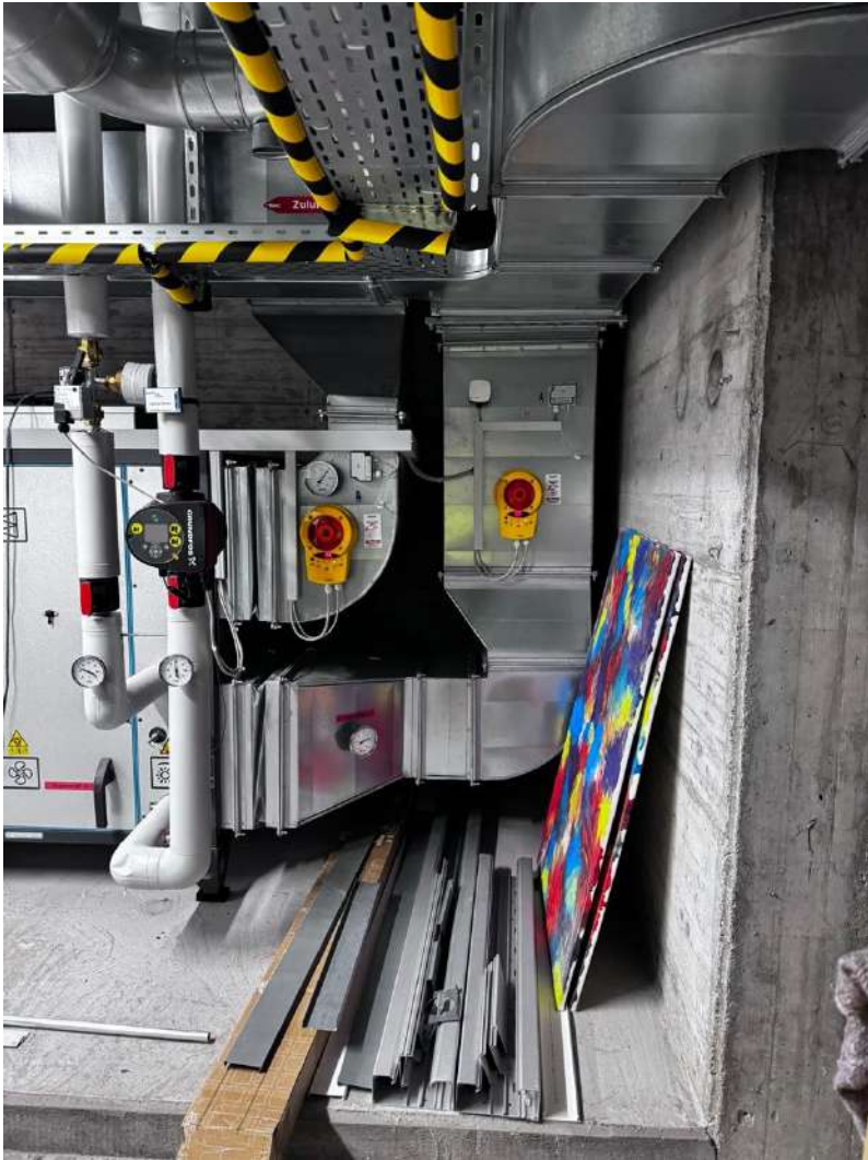
Lüftungs- und Abwasserkanäle
